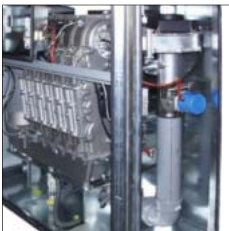
Innenansicht mit Zuluftklappe nach Einbau
