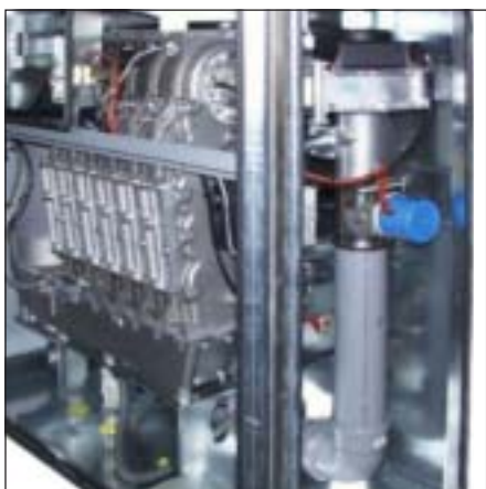
Vista interior con compuerta de aire de entrada después del montaje
