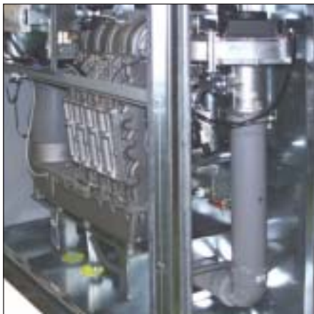
Vista interior sin compuerta de aire de entrada
