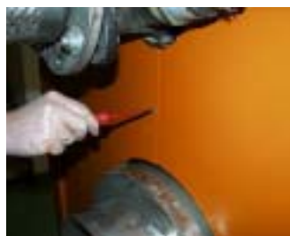
Verschraubung der Verkleidungsbleche zueinander
