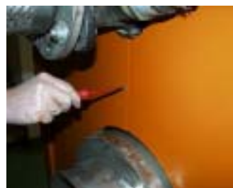
Verschraubung der Verkleidungsbleche zueinander
