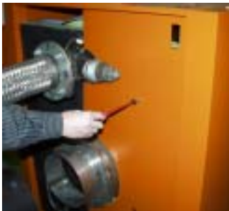
Verschraubung der hinteren Verkleidungsbleche ans HIinterglied
