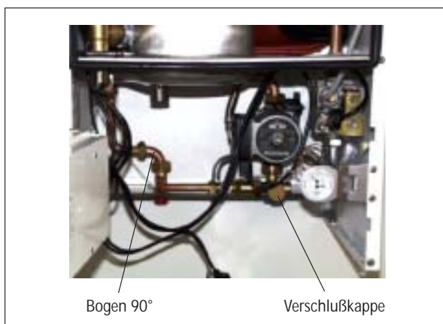
Bild 2: Vorbereitung zum Einbau
