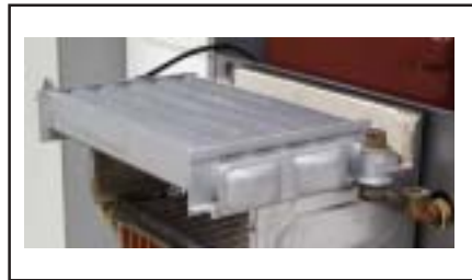
Bild: Demontage Heizwasserwärmetauscher
