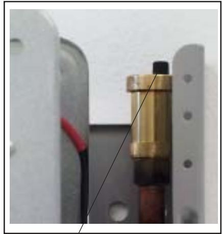
Bild: Entlüfterschraube am Schnellentlüfter
