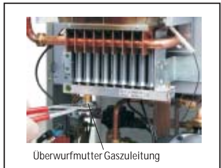
Bild: Brenneinheit ausbauen
