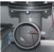
Abgastemperaturfühler im Kunststoffbogen
